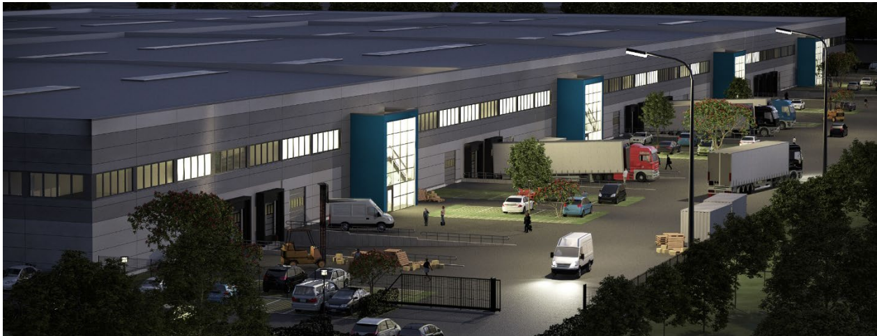
Bildquelle: © MP Holding GmbH, M-PORT 3 Mönchhof
