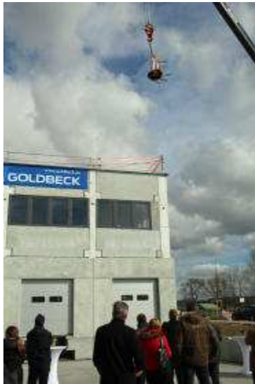
Foto: Carmen Erlenbach Hoch über den Köpfen schwebte der bunt geschmückte Kranz zum Richtfest
