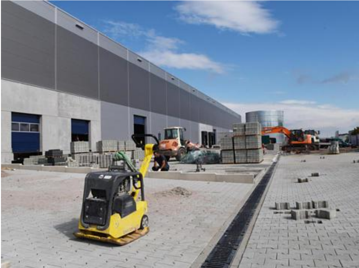
Die neue Halle ist schon fertig, aber es sind noch Restarbeiten zu erledigen. Foto: Renate Hoyer
