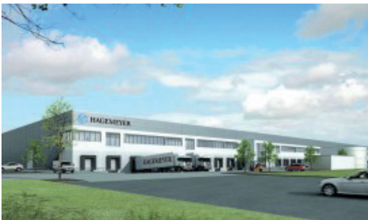
20.000 m 2 Lagerfläche entstehen in dem neuen Lagergebäude von M1.
