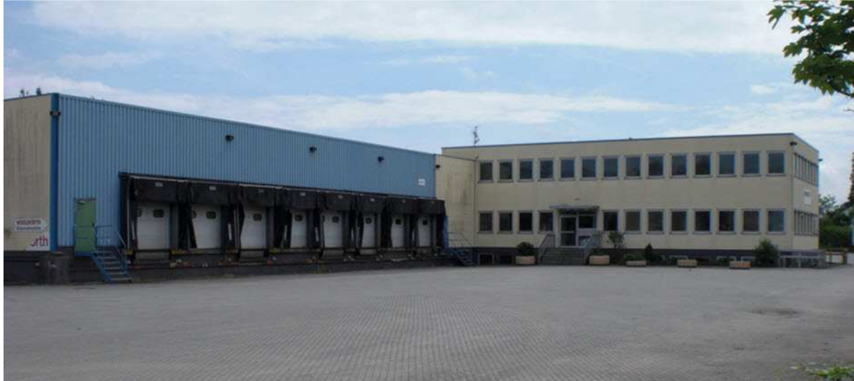
MP Holding Bestand Langen vor Sanierung
